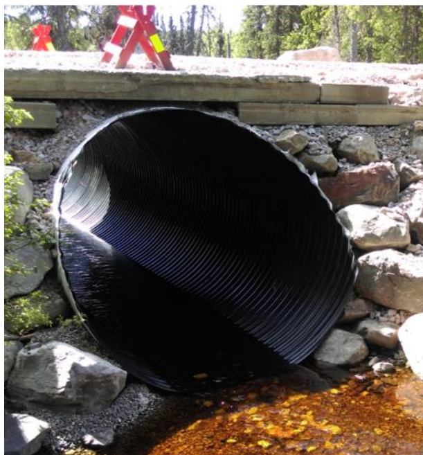
Nytt rør i Præstsæterbekken i vegen over til Vang
